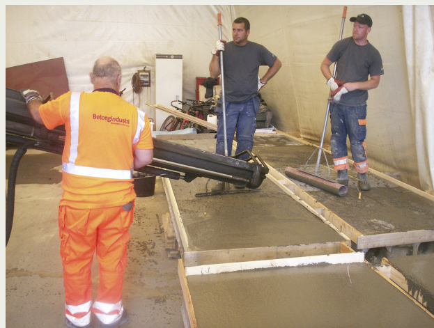
Figur 2. Utförande av pågjutning på håldäckselement inom aktuellt projekt.
