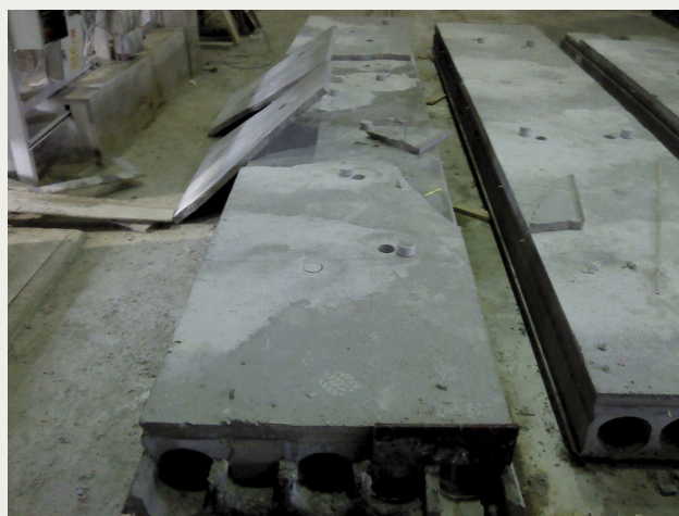
Figur 4. Bristen på vidhäftning illustreras av att delar av pågjutningen kunde lyftas bort.
